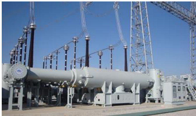
1100kV SF 6 气体绝缘金属封闭开关设备
