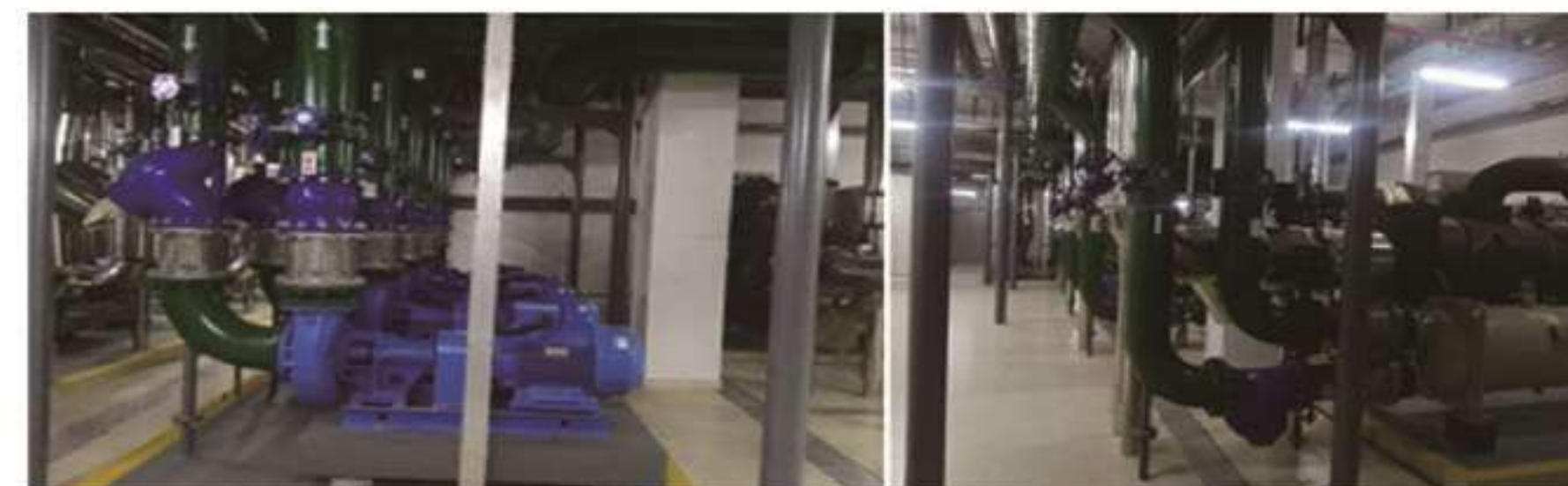
机房设备及管道现场预制----装配式施工实况一
