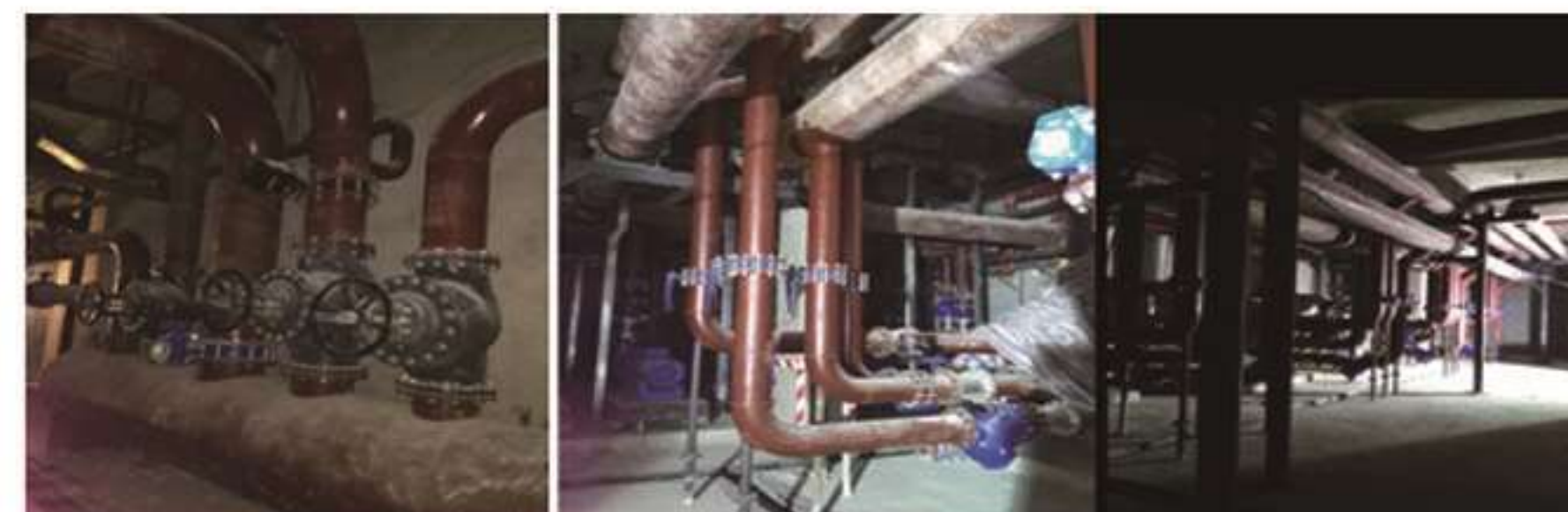
机房设备及管道现场预制----装配式施工实况二
