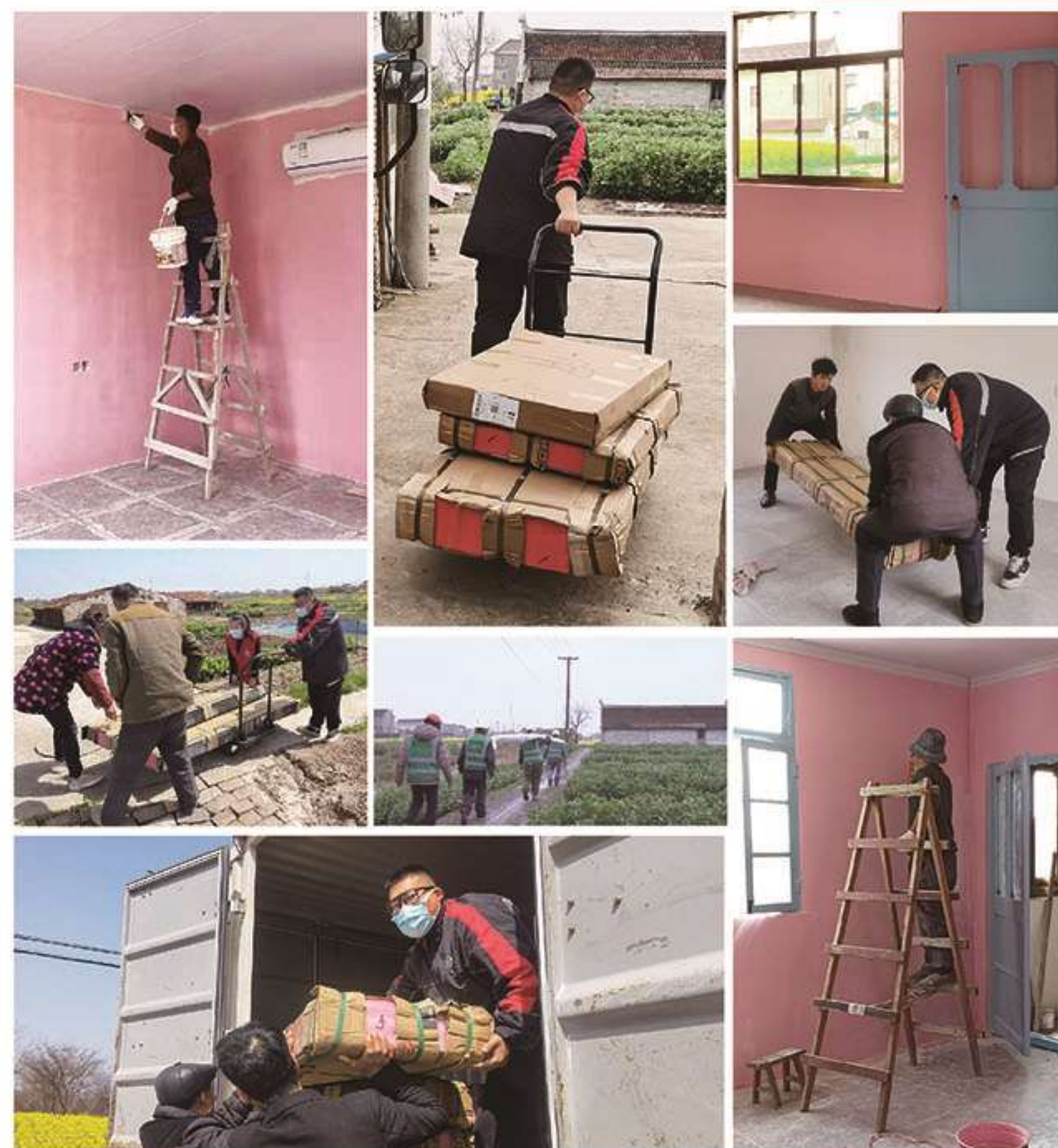
施工过程记录
