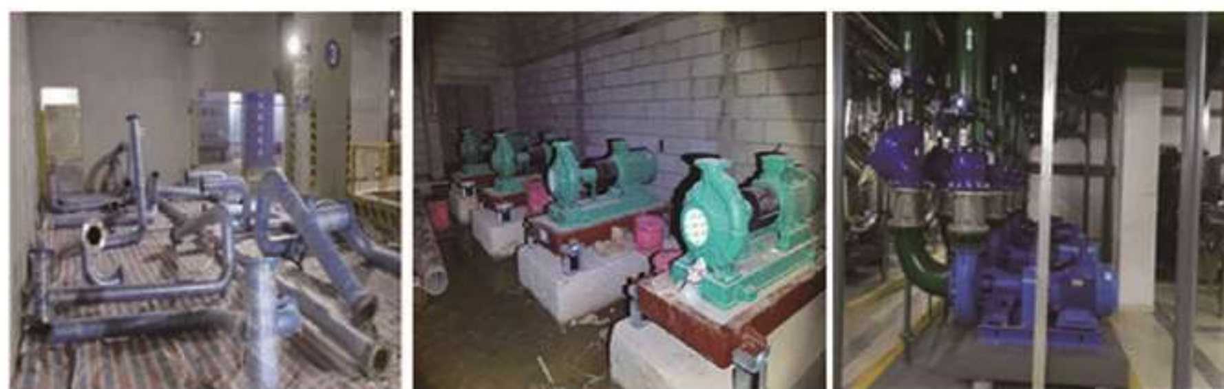
水泵机房设备及管道现场预制----装配式施工实况
